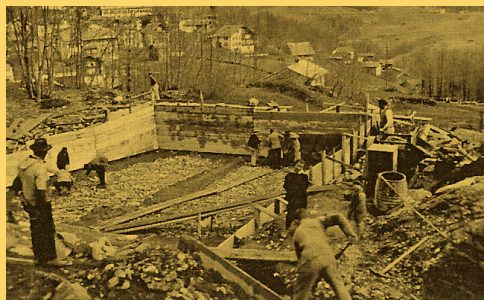
Die Basin-Schalung nimmt Form an.
